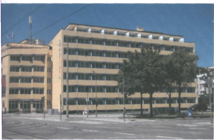
DasA&O Hostel & Hotel in München in der Arnulfstraße vereint Hostel und Hotel unter einem Dach.
