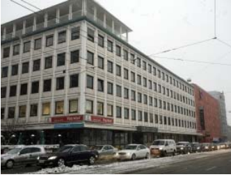
Das Bürogebäude in der Bahnhofstraße 13-15 soll bis Frühjahr 2011 zum A&O Hotel und Hostel umgebaut und renoviert werden.
